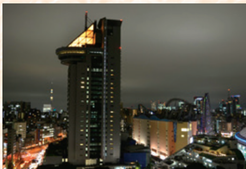
▲ オレンジ色にライトアップされたシビックセンター
